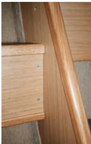
Unsaubere Details: verdrehte Schrauben und breite Fugen
